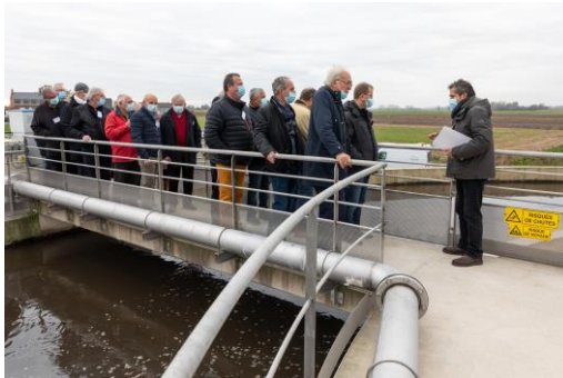
Explications sur le bassin d'aération.
