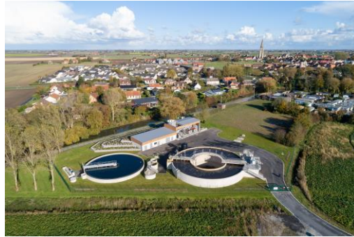
Vue aérienne de la STEP.
