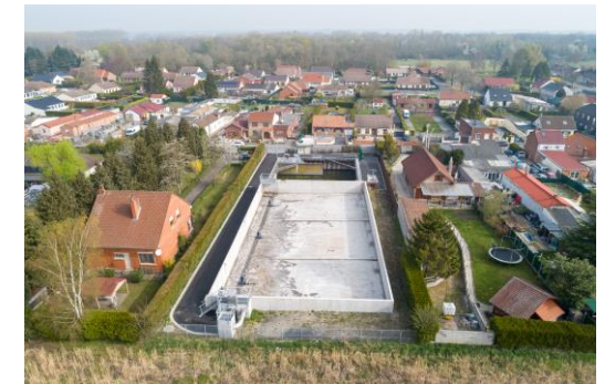
Vue aérienne du bassin.
